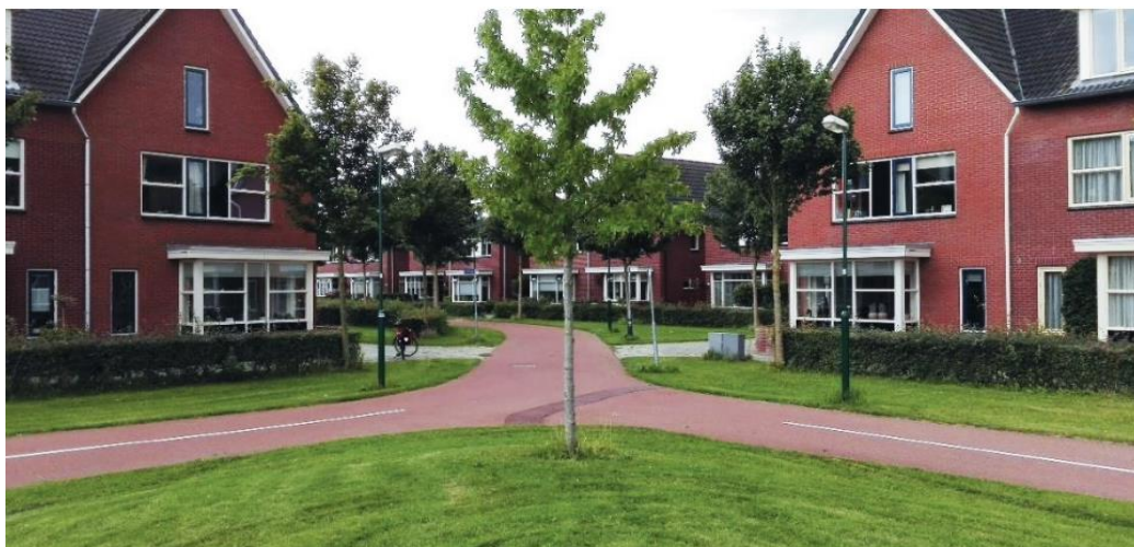
Rysunek 1.6. Droga dla rowerów (bez jezdni samochodowej) obsługująca obszar zamieszkania, Houten, Holandia.
