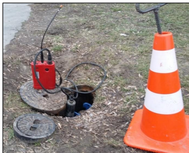
Rysunek 3. Rozmieszczenie nadajnika korelatora MicroCorr firmy Palmer.
